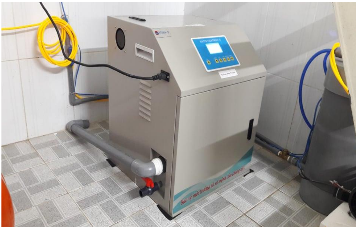
Lắp đặt thiết bị xử lý nước thải y tế cho các phòng khám
