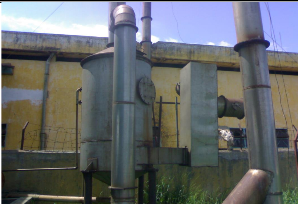
Lắp đặt hệ thống xử lý khí thải N.M Chế biến bột cá
