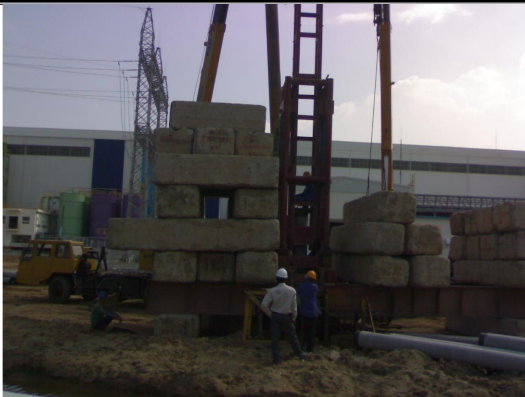
Công đoạn ép cọc trước khi xây dựng HTXLNT N.M Thép Posco VN
